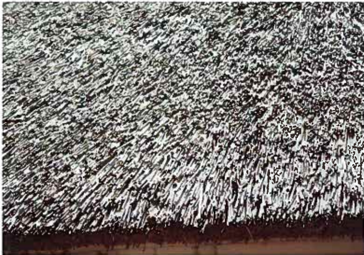
Rieten dak uit 2008.
