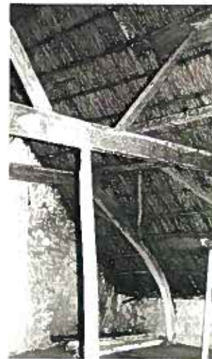
afb.7. De zolder vóór de restauratie, met een krommer, het vlooiendak en een aantal stutten om het doorzakken van het dak op te vangen.
