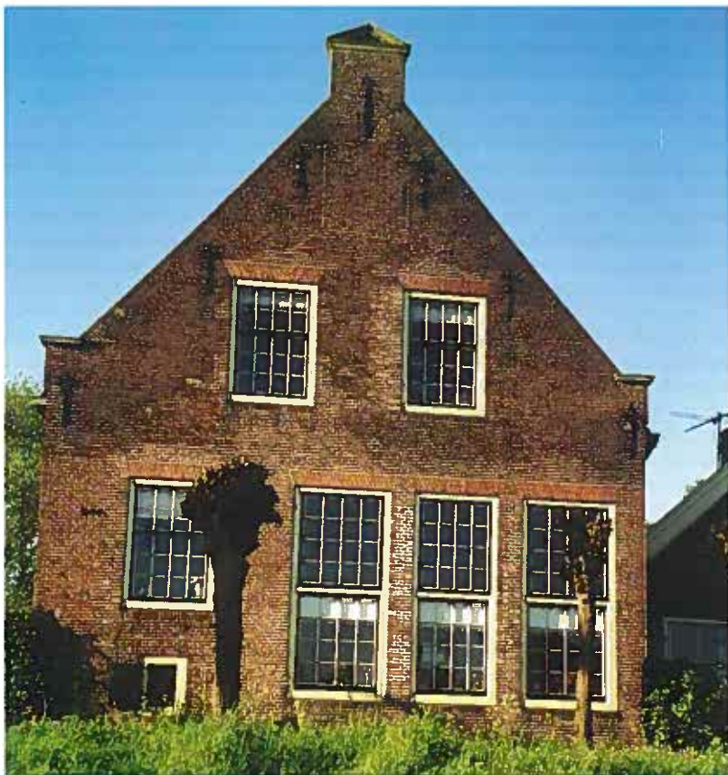
afb.4. Voorgevel na de restauratie.
