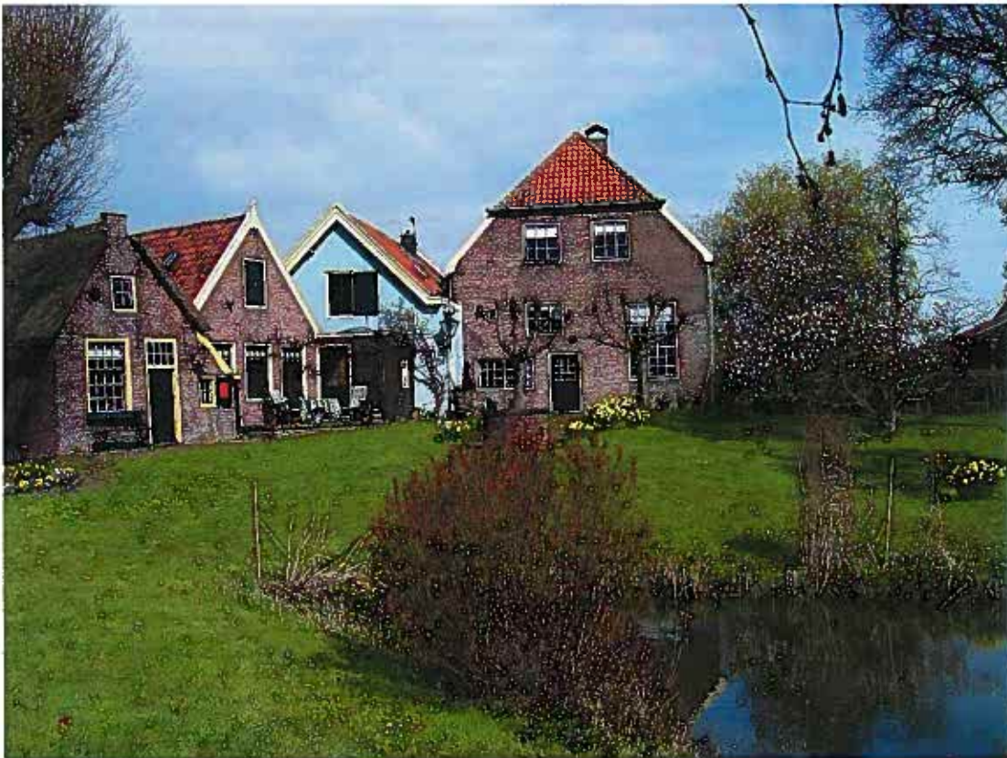
afb.8. Overzicht van de huidige situatie aan de achterzijde.
